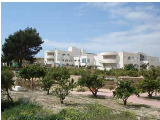
Solgården's siste utgivelse, Bygg 7, huser bl.a. en hyggelig kafeteria. Rett utenfor er det en flott solterrasse med svømmebasseng og fin utsikt.
